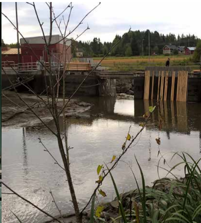
Työpadon asentamista varten veden pintaa pudotettiin ja samalla uusittiin vanhemmat neulapadon neulat.
