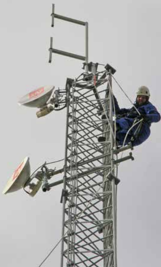
Tukiaseman antennin asennus käynnissä.
