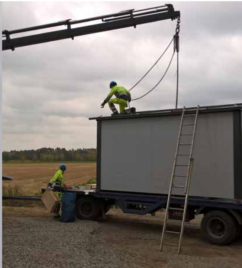
Kompensointilaitteiston suojarakennuksen paikalleen nosto.
