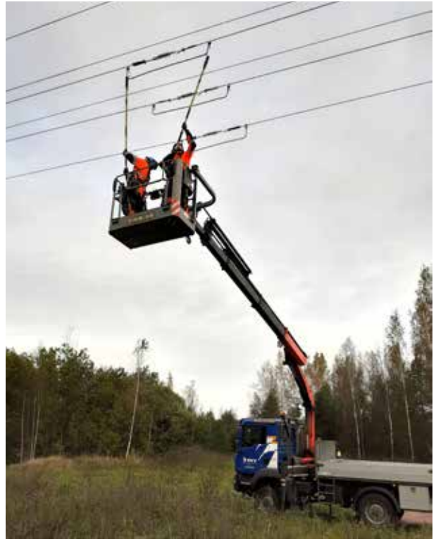
Verkostoasentajat Riku Tapaninen ja Kasper Alho näyttävät, kuinka jännitetyösauvojen avulla voidaan irrottaa jompeja. Toimenpidettä voidaan käyttää esimerkiksi katkoalueen rajaamiseen.
