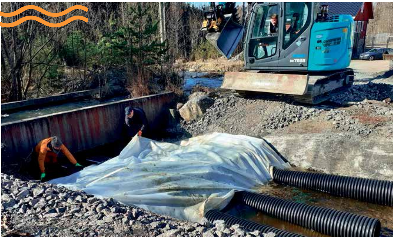
Pyhjärvi-instituutin Ville Kangasniemi ja Lauri Anttila asettelivat suodatinkangasta, kun Lasse Heikkilä odotti seuraavaa siirtoa.
