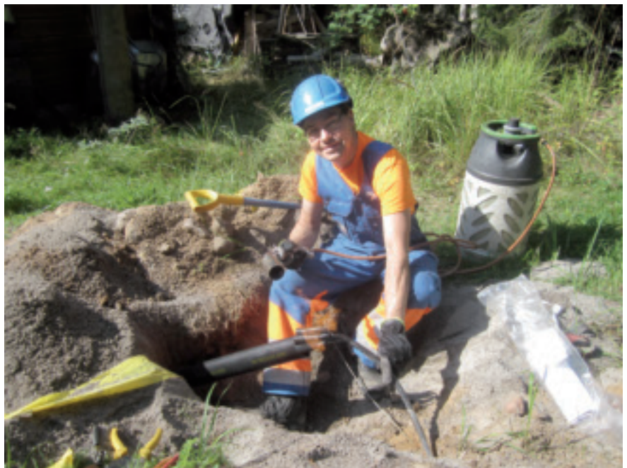
Uusi maakaapeli liitettiin vanhaan maakaapeliin jatkosholkein.
