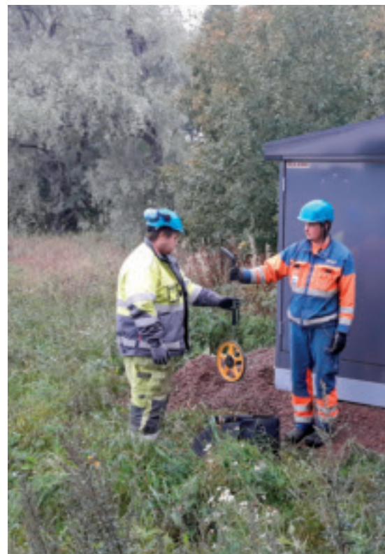
Vanha pylväsmuuntamo korvautuu uudella puistomuuntamolla. Riku Tapaninen (kesk.) antaa ohjeita maadoitusmittaukseen. Eetu Suomiselle (vas.) Riku opiskelee työn ohjeita. Maadoitusmittaus on osa näyttökoetta, jota valvomaan johtaa Eetu Suomiselle (oik.) Winnovasta. Eetu puolestaan opiskelee sähkö- ja Kokemäellä.
