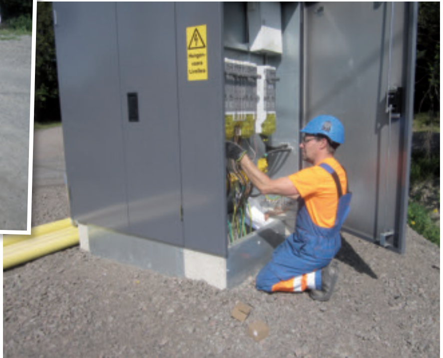
Sulakkeiden paikalleen laittoa keväällä valmistuneeseen muuntamoon.
