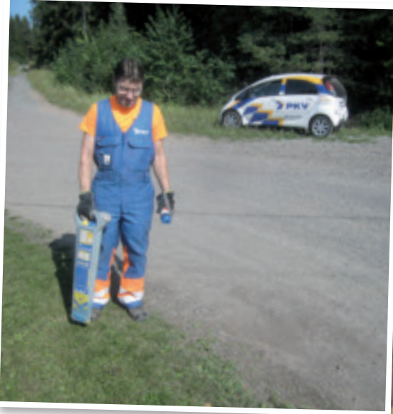
Kaivuualueelle tarvittiin kaapelinnäyttöä.
