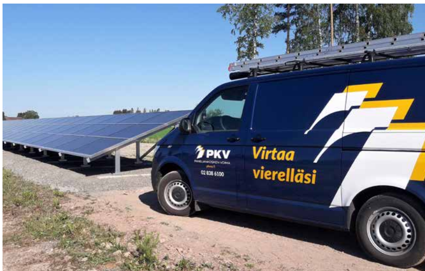
Vertek Sähköpalvelu Oy asensi Kaalperkon aurinkovoimalan PKV:n aliurakoitsijana.
