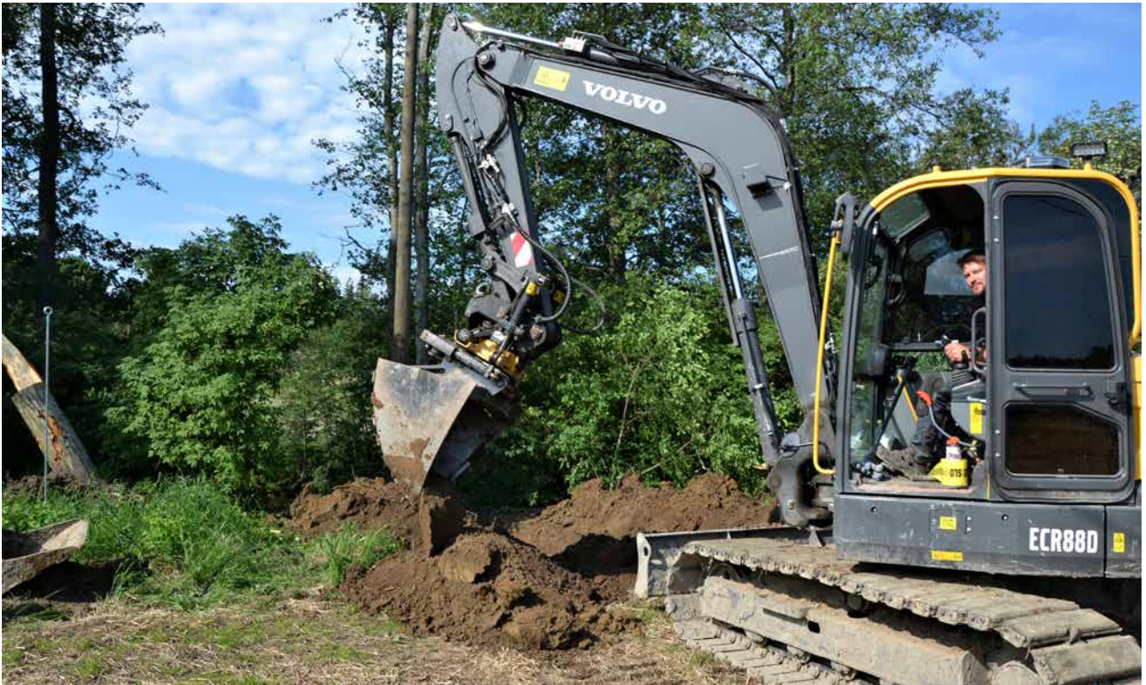
Eurajokelainen Lasse Heikkilä on yksi PKV:n yhteistyökumppaneista, joka auttaa kaivutyössä. Kesäkuussa sähköä vietiin uuden tielinjauksen vieressä joen yli ilmalinjana.
